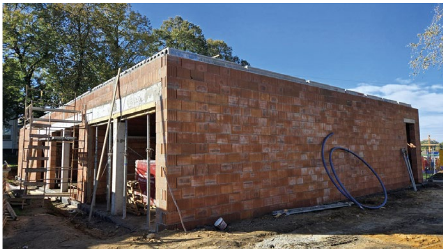
Wznoszenie ścian nowoczesnego Żłobka Gminnego w Wojkowicach Kościelnych
