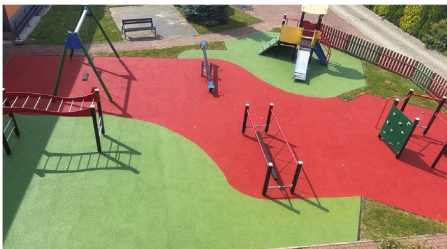
Bezpieczna nawierzchnia poliuretanowa na placu zabaw przy Szkole Podstawowej w Brudzowicach
