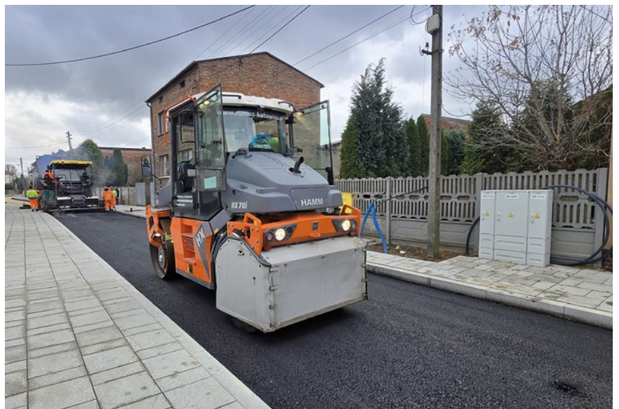
Ulica Ludowa doczekała się zupełnie nowej nawierzchni
