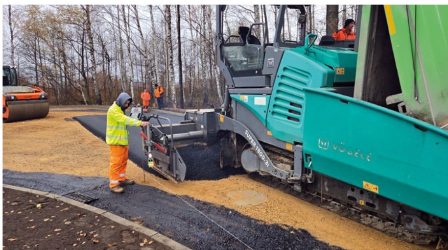
Pokrywanie asfaltem nawierzchni ulicy Zawodzie w Wojkowicach Kościelnych
