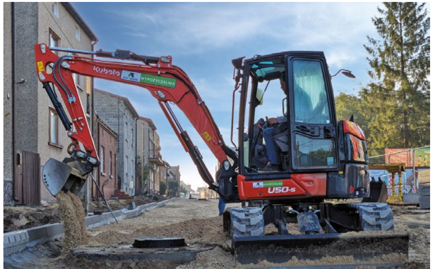
Prace ziemne, od których rozpoczęła się kompleksowa przebudowa ulicy Piłsudskiego w Siewierzu
